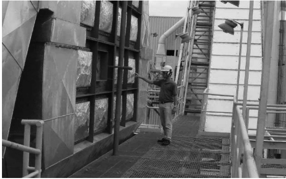
写真1 安全空間への放爆が必要だが一危険な例
